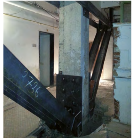
30. 1. 2020 Nosná konstrukce ve sklepe
