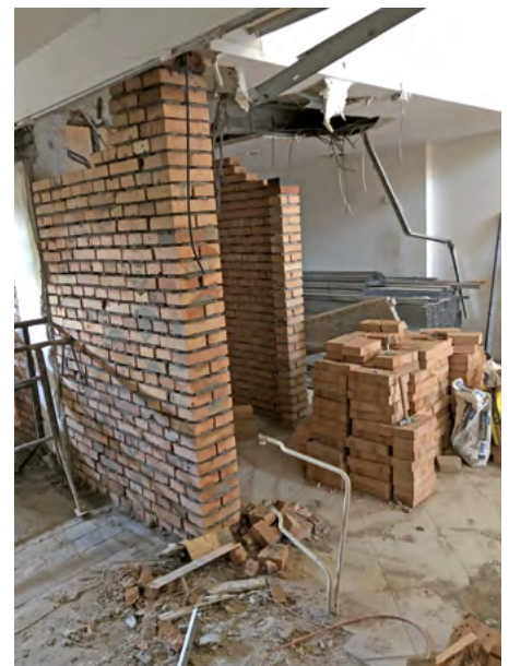
9. 2. 2020 Nová výtahová šachta
